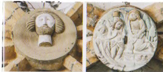
Kamnoseško obdelana sklepnika na oboku ladje
