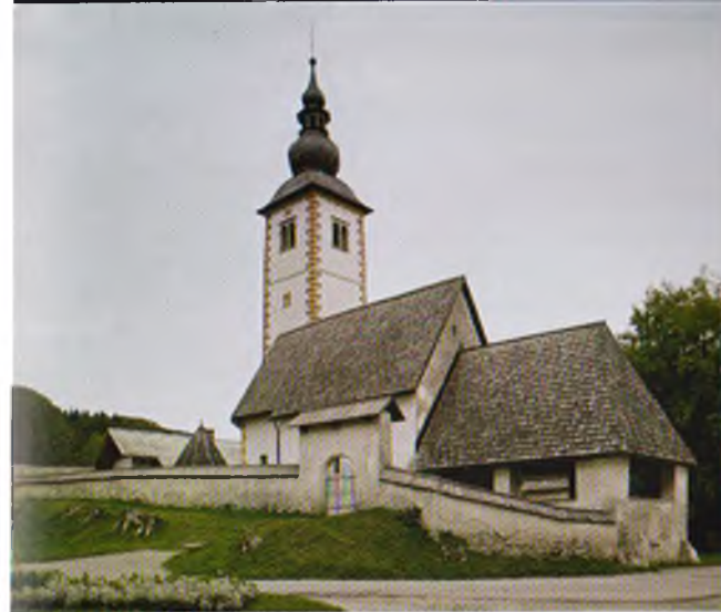
Pogled na cerkev sv. Janeza Krstnika s severozahoda
